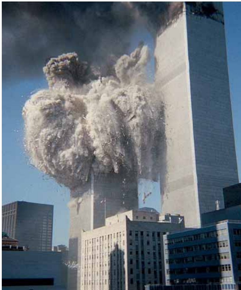
De instorting van de zuidelijke wtc-toren. De stalen balkfragmenten worden tientallen meters horizontaal de lucht in geslingerd. (Vergelijk p. 48, 214.)
